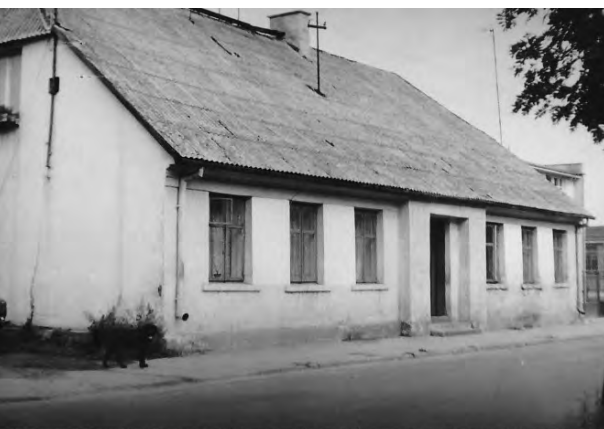
⤴ Nieistniejący budynek przy ul. T. Kościuszki nr 18, obok Bank Pekao BP
