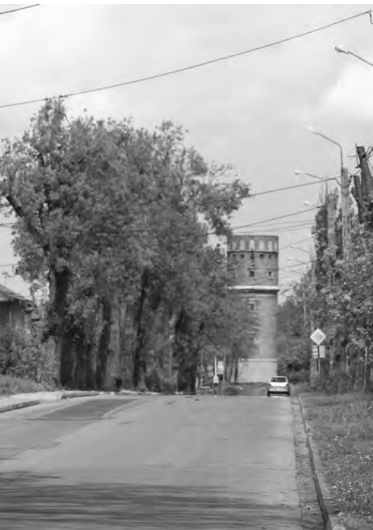
⤴ Wieża ciśnień należąca do stacji kolejowej, obecnie nieczynna
